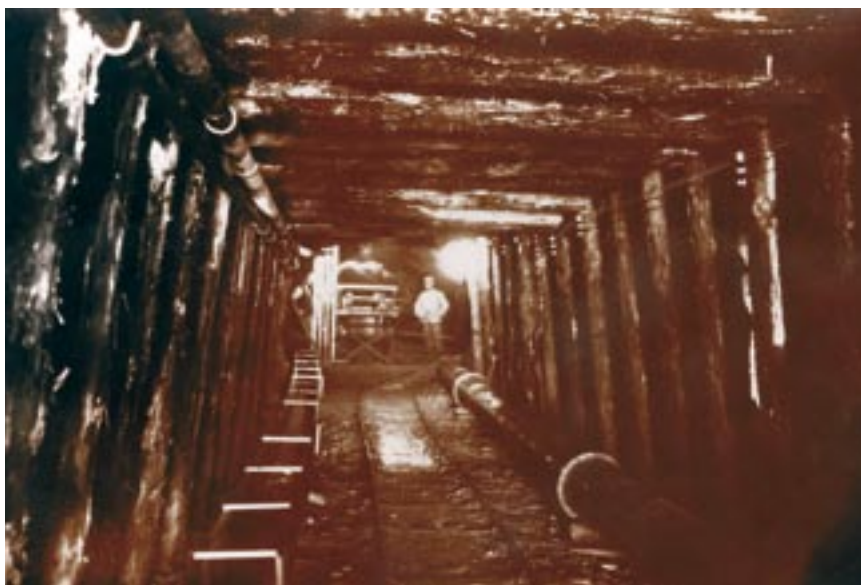
L’interno di un tratto della galleria che porta l’acqua del nostro lago alla centrale: visibili i pali di sostegno ed il binario per i carrelli
