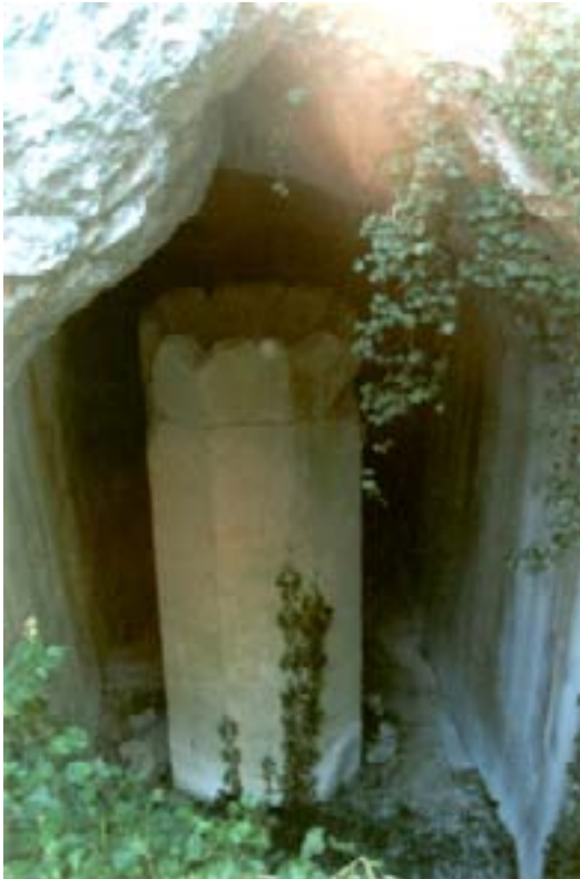
Uno scorcio del serbatoio scavato nella roccia con il grande manufatto del "troppo pieno"
