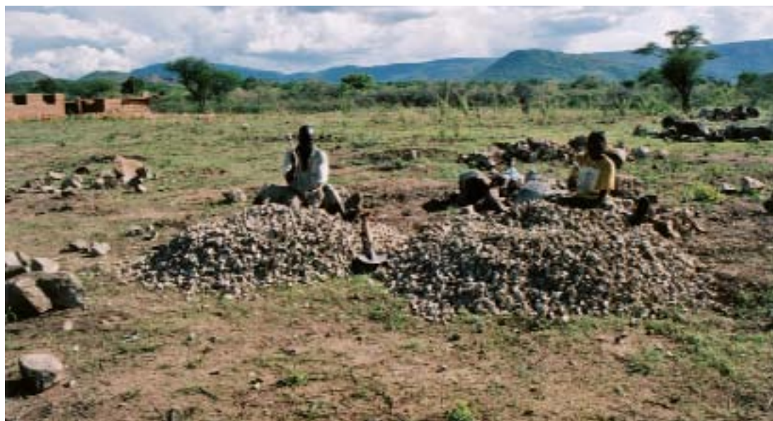
Ibwanzi: i ragazzi preparano a mano la ghiaia per il calcestruzzo
