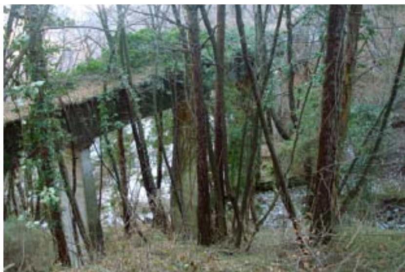
Un tratto, assediato dalla vegetazione, del lungo canale che portava l'acqua del Ponale al serbatoio sopra la vecchia centrale
