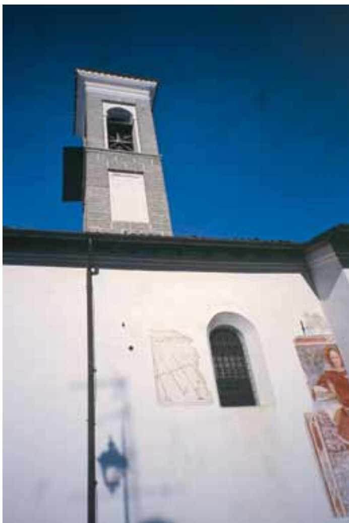
Campanile di Mezzolago
