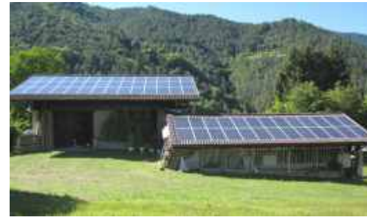
Un impianto realizzato tramite la cooperativa So.L.E.
